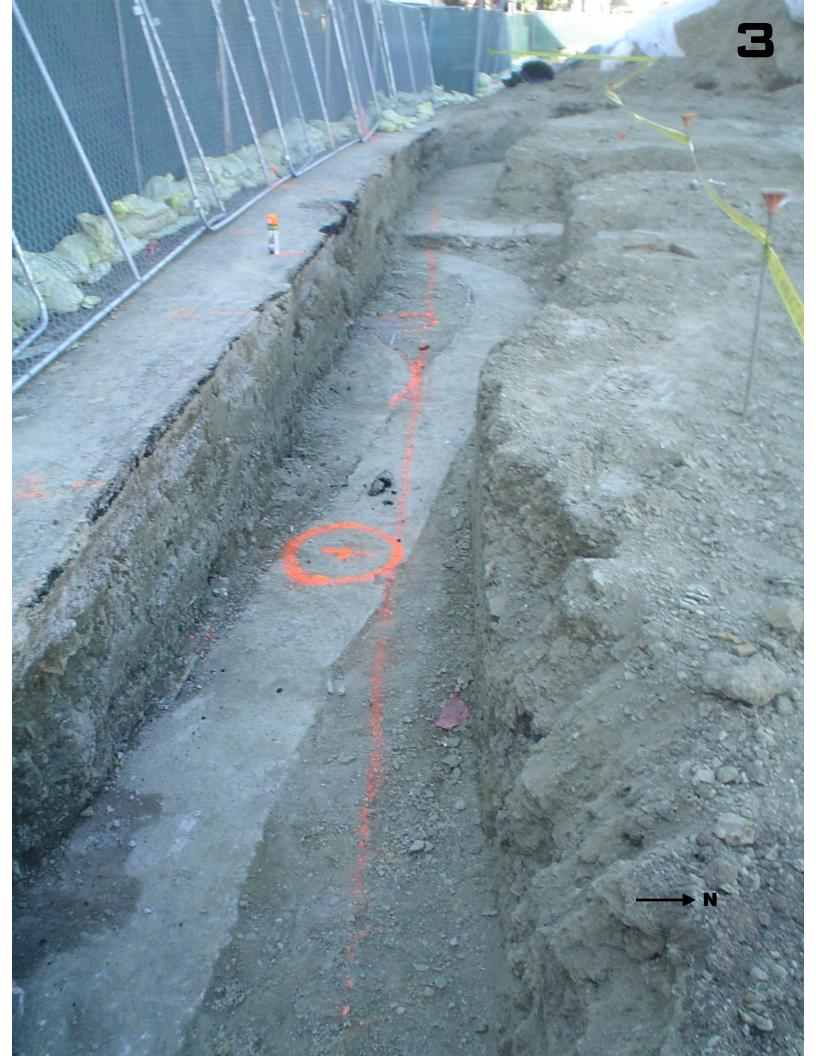
a C. Bid Planned edge of Bren Hall foundation Telecom Conduits PLANNED LOCATION OF Electrical Conduits **BREN HALL**
